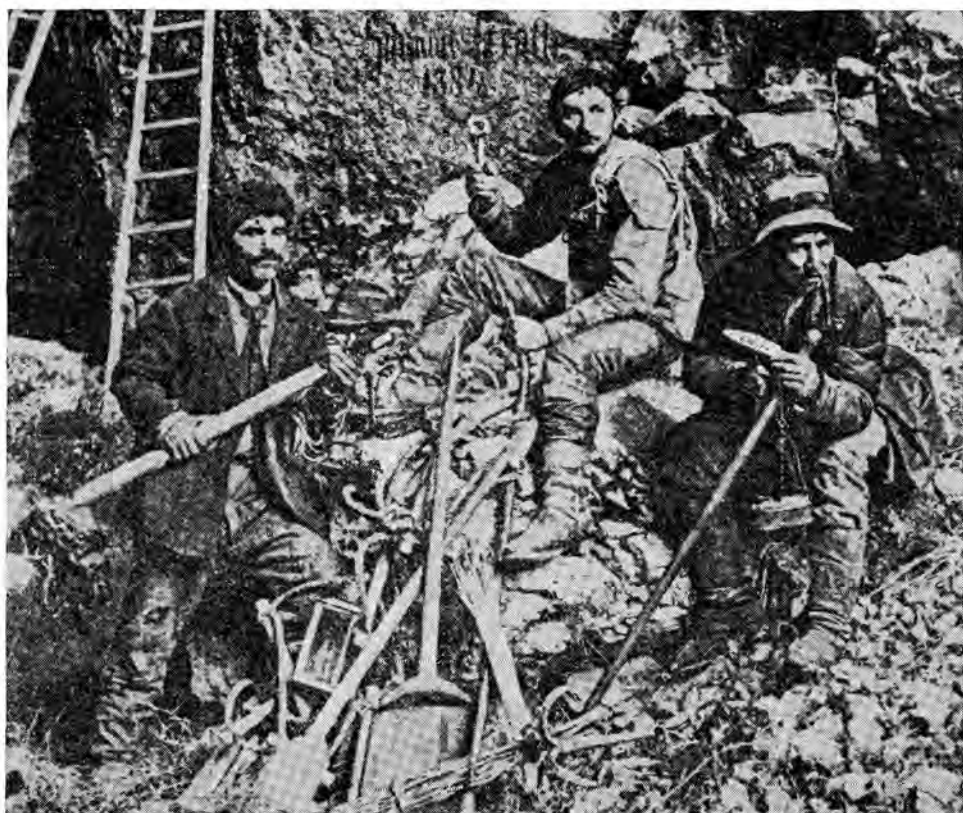
Sl. 1 — Jamski delavci in vodniki iz Škocjanskih jam. Delavec na desni drži v roki na verižici obešeno oljenko (A. Pazze 1893, str. 359).
