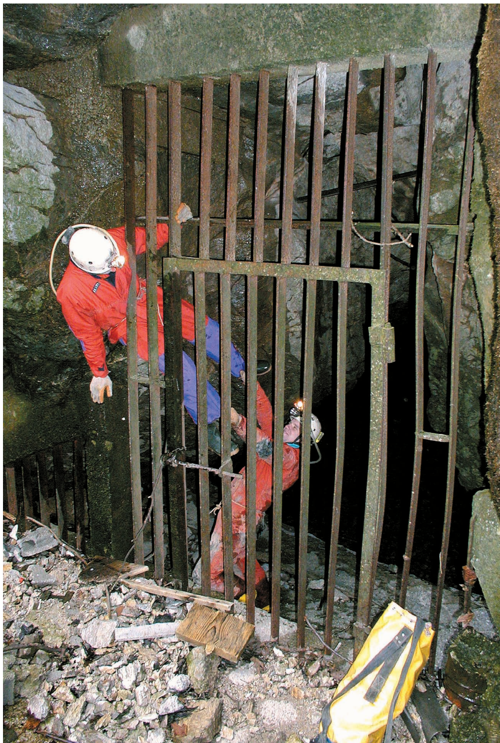
Pred požiralniki so narejena železna vrata, ki zadržujejo naplavine, pa tudi jamarje. Foto: Miran Nagode
