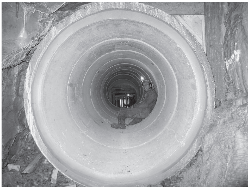
Slika 6: Betonska cev omogoča dostop v jamo iz tunela. Foto: Franci Gabrovšek.
