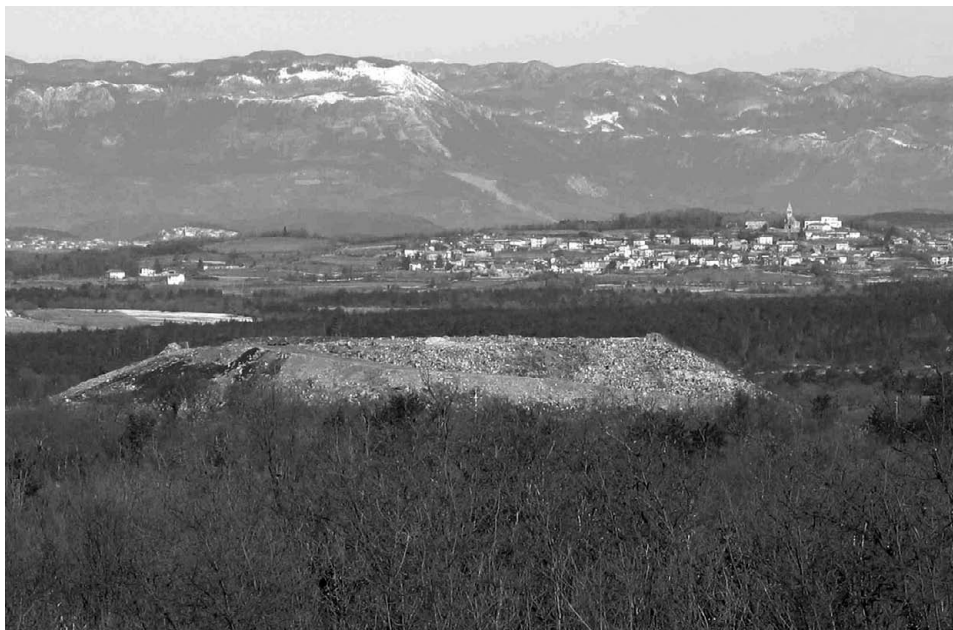
Slika 1: Odlagališče komunalnih odpadkov v Sežani leži v vrtači, na močno zakraselem območju. Telo odlagališča se že formira v nasip. Foto: N. Ravbar.
