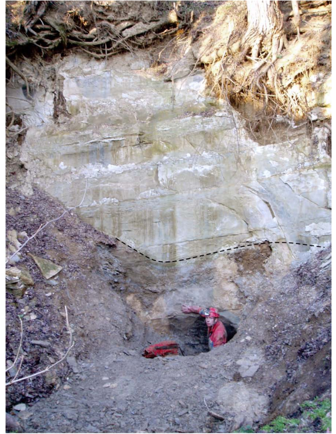
Slika 10. Prekinjena črta označuje nivo nasutega materiala, ki ga je bilo treba odkopati, da se je vhod v jamo spet odprl.
