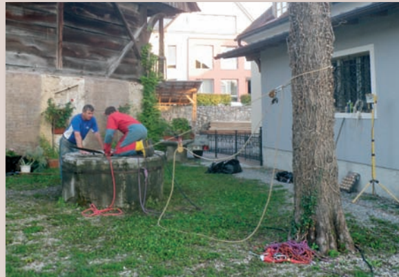
Pred začetkom čiščenja
