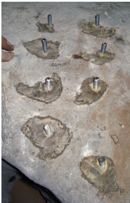
Zalepljene navojne palice
