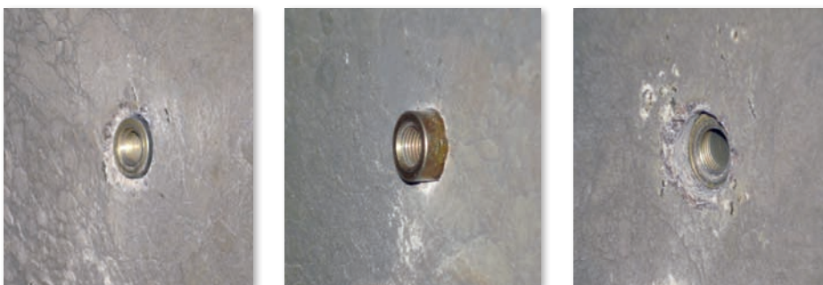
En pravilno in dva nepravilno zabita svetrovca
