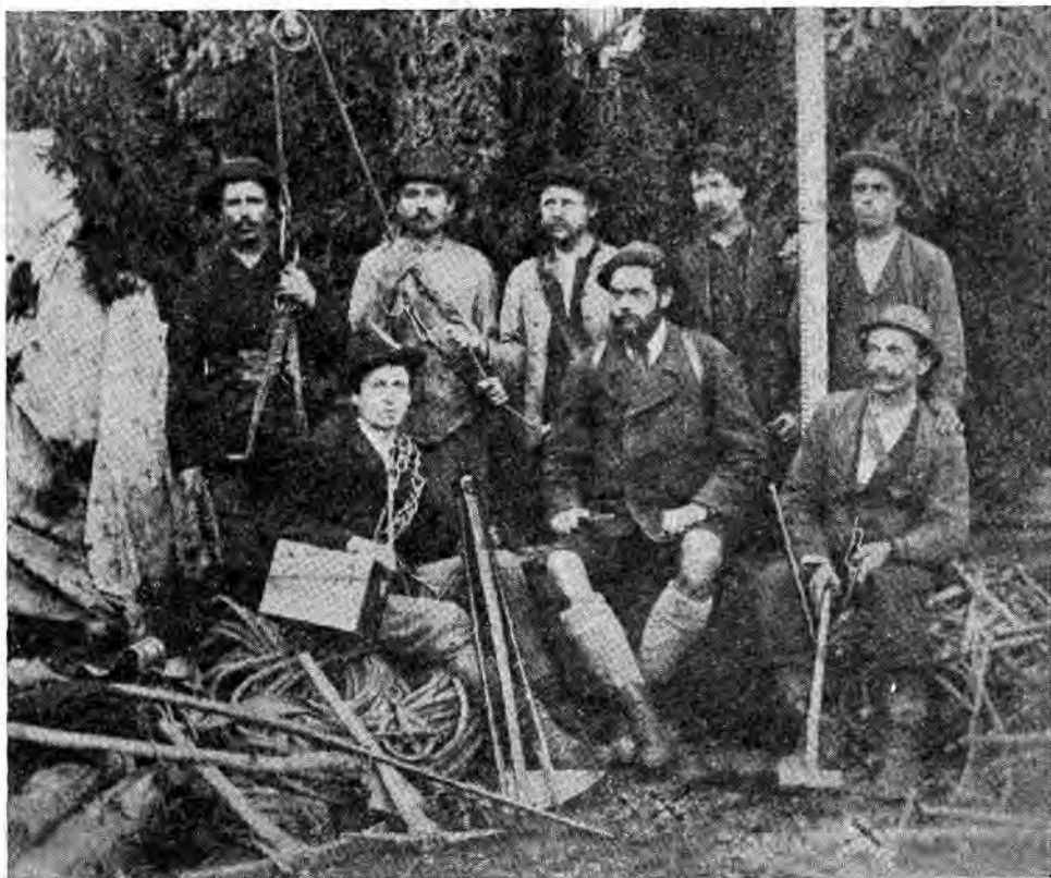
V. Putick med svojimi delavci. Na njegovi desni sedi delovodja J. Šturm.
